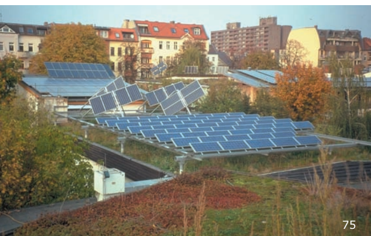
Abb. 73 bis 76: Beispiele für die Kombination von Photovoltaik und Dachbegrünung
