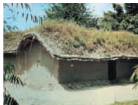
Abb. 11: Grasgedecktes Haus in Tansania
